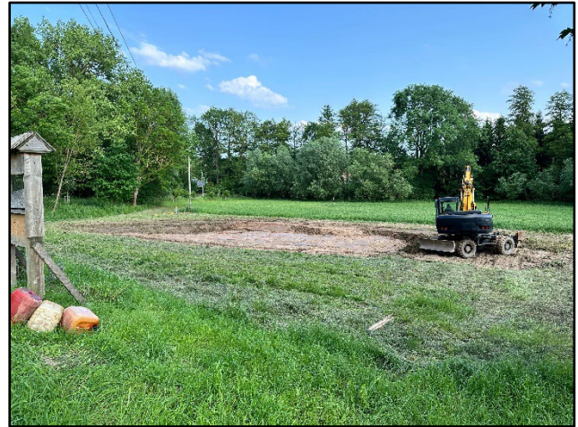
Im Juni begannen die Arbeiten auf der Wiese hinter dem Mühlteich
