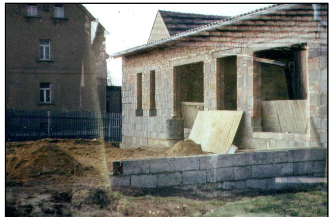
Rohbau des neuen Konsums
