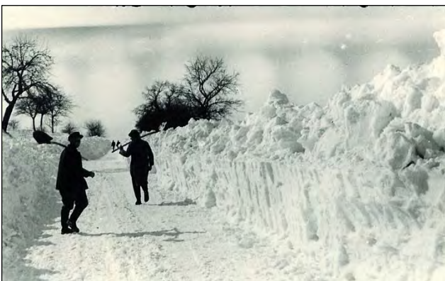
Die Straße nach Baldenhain muss mit Schaufeln vom Schnee befreit werden
