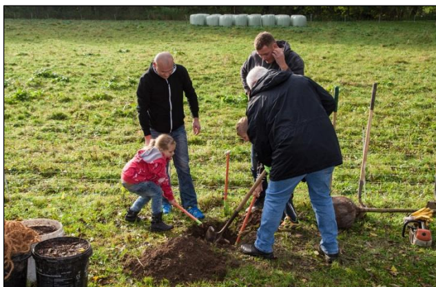
Ausheben der Pflanzgrube
