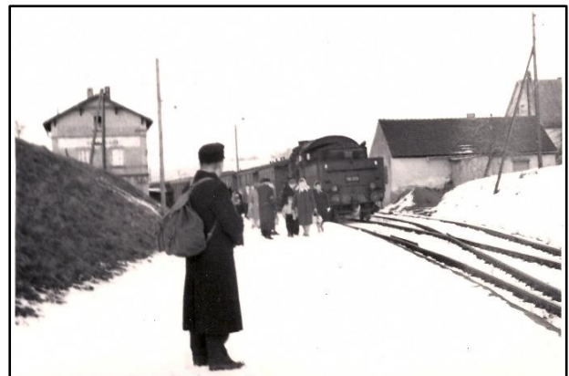
Bahnsteig am Frankenuauer Bahnhof
